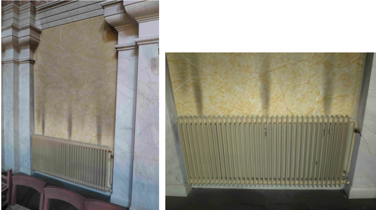
Figur 23. Accentuerad svärtning över radiator i stenkyrka.
